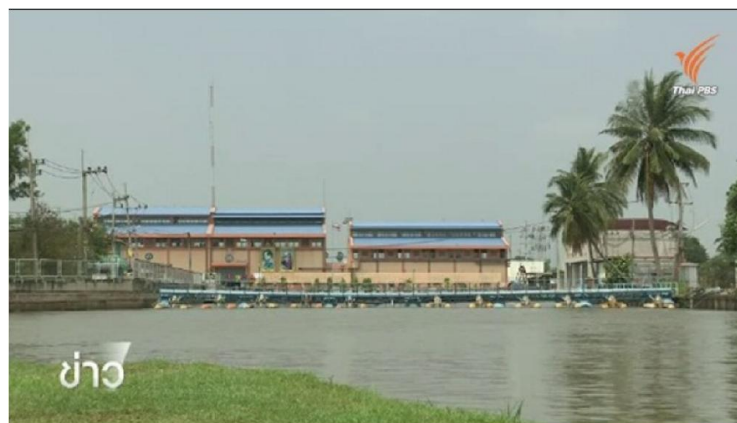
รูปที่ 1.4 สถานีสูบน้ำดิบสำแล จ.ปทุมธานี
